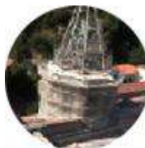
Obres de restauració de les cobertes de la Biblioteca del Monestir
